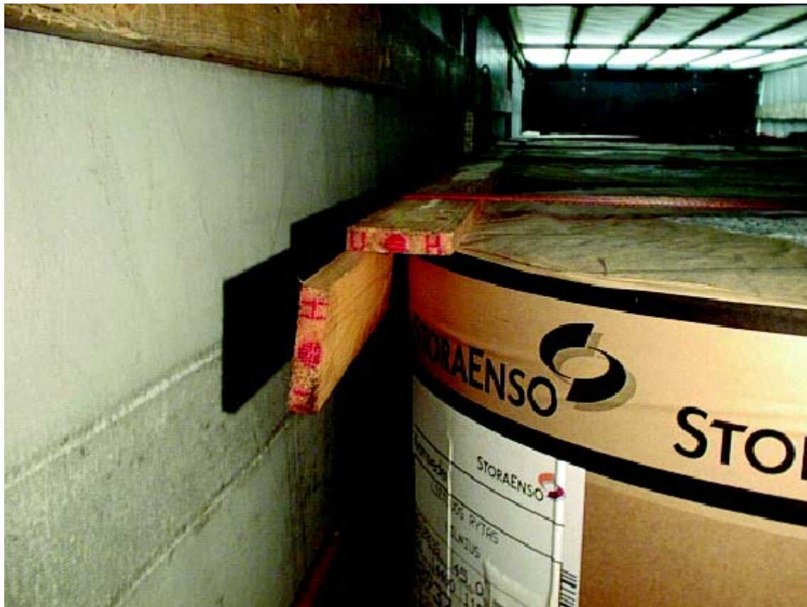
Imagen 37: Viga de borde fabricada con tablas de madera.
